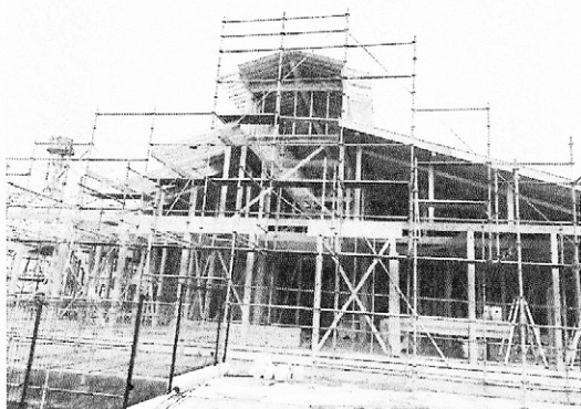
福岡県某幼稚園の木造建築物の構造部材加工と木質建材を納めた
